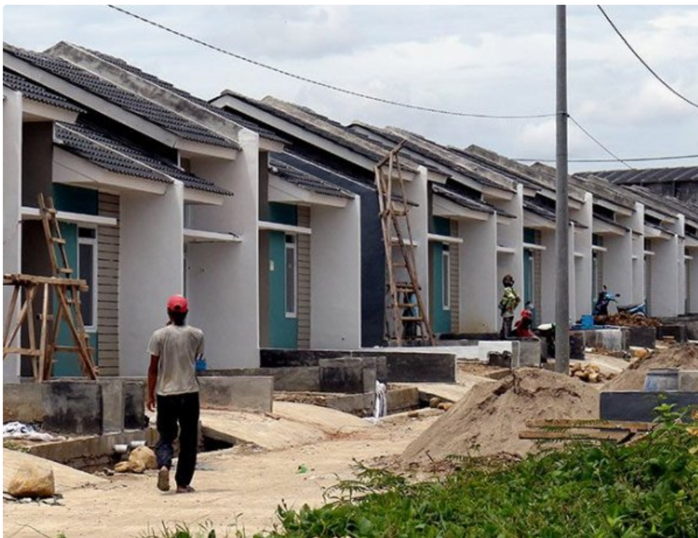
Pembangunan rumah subsidi di Citeurep, Kabupaten Bogor, Jawa Barat
